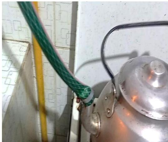
Figura 8. Paso 1, ajuste de la manguera con abrazadera a la caldera.
